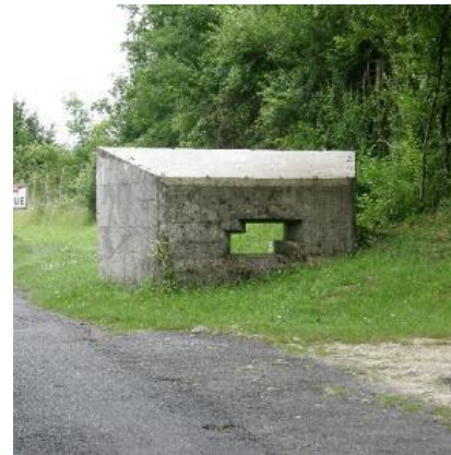
Casemate Chauvneau à Mont-l'Évêque
