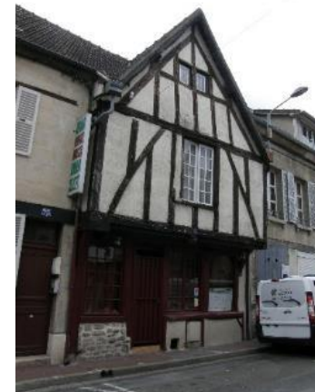
Maison à pans de bois à Pont-Sainte-Maxence
