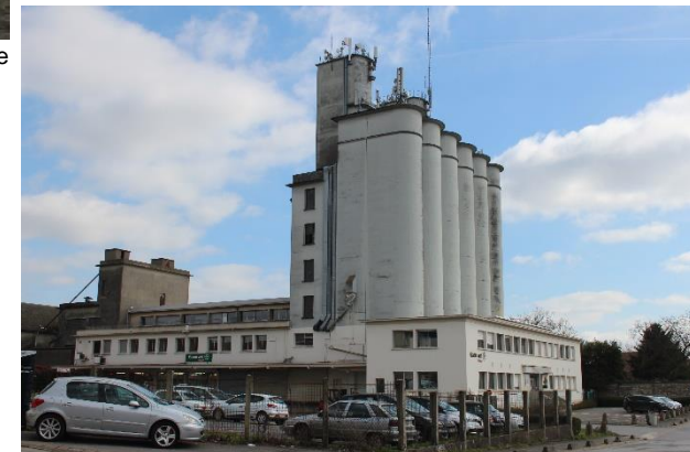
Silo à Senlis
