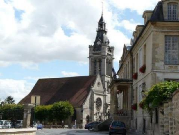
Eglise Saint-Pierre et Saint-Paul à Viarmes
