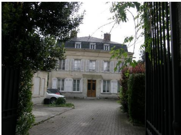
Maison de notable à Précy-sur-Oise
